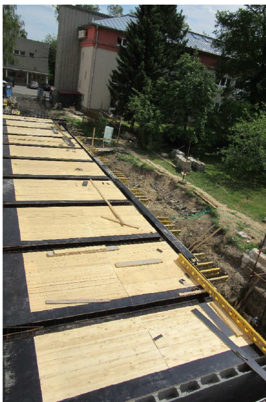
Obrázek 7 - strop nových šaten venku finišuje, připravuje se na betonáž.
