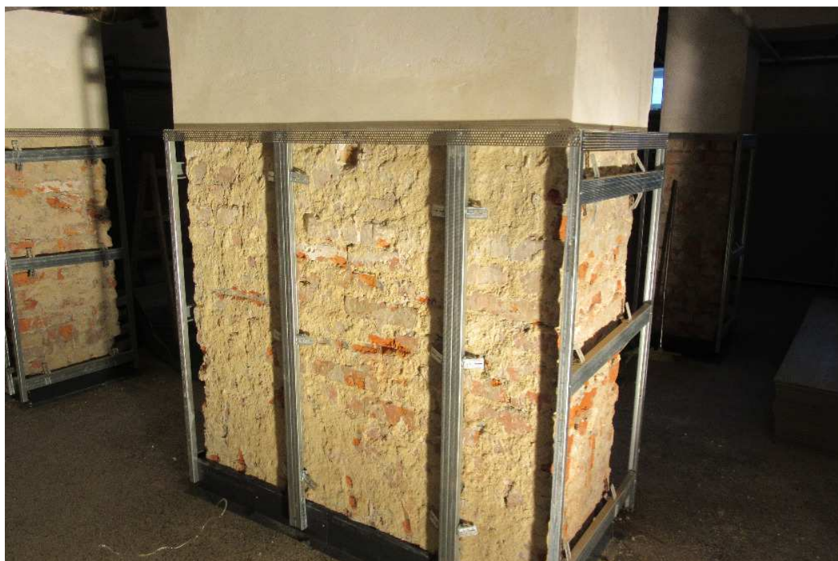
Konstrukce pod obklady
