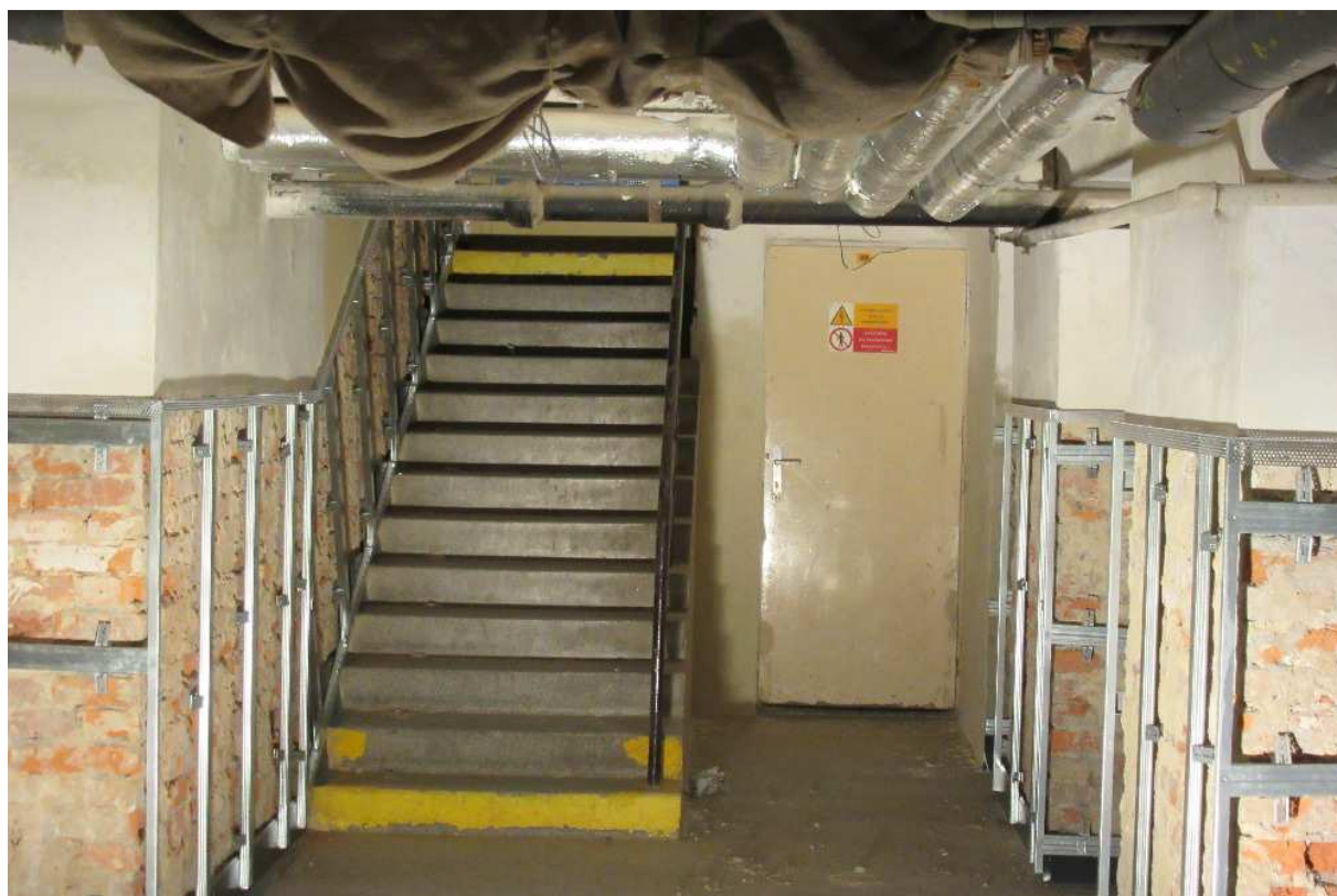
Schody do šaten a malé tělocvičny
